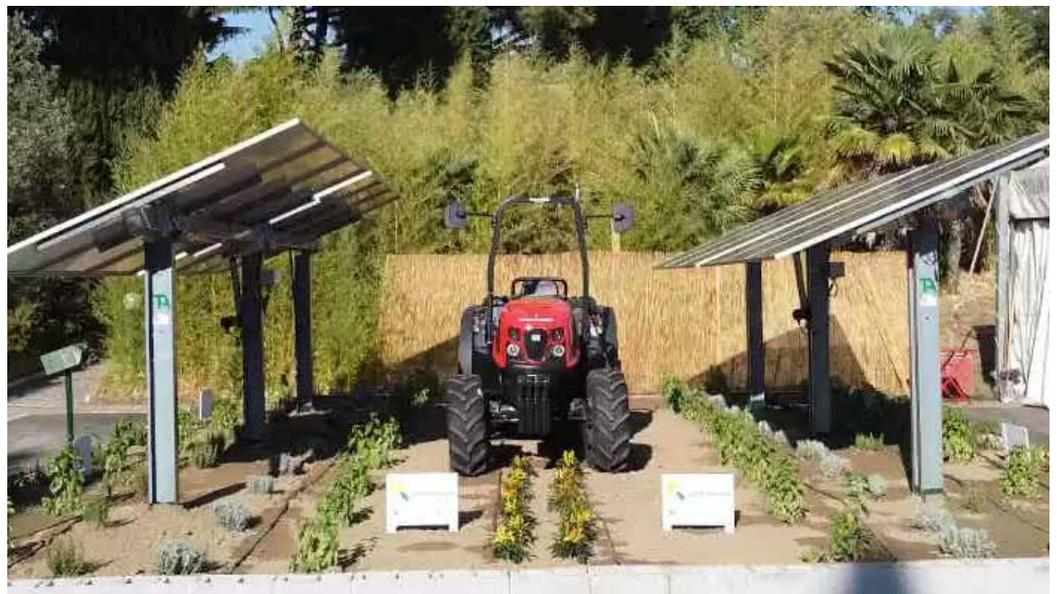
ta), pannelli mobili e coltivazioni agricole. In particolare, si tratta di un piccolo impianto in scala reale realizzata in un'area di 80 metri quadri situata all'ingresso della manifestazione di Legambiente, con due file di sei tracker dove sono installati altrettanti pannelli fotovoltaici mobili a 2,30 metri di altezza dal suolo, che si orientano verso la luce solare.
